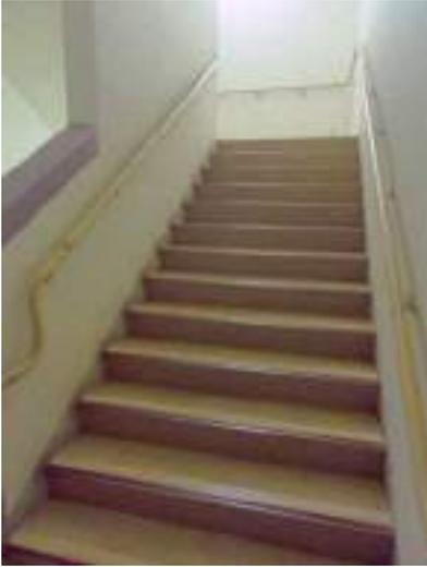
比較的緩やかな傾斜の階段、また両側に手すりを設置してあり、転倒、転落防止の配慮がされています。
