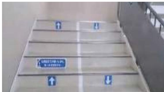
階段の上り下りの方向を明示し安全な通行としています（できれば壁側にも手すりが望まれます）。
